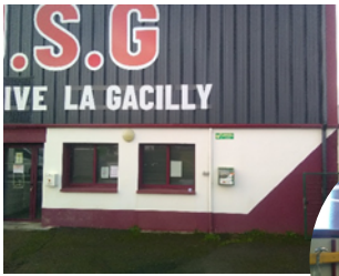
Stade de Foot (façade + vestiaire arbitre)
