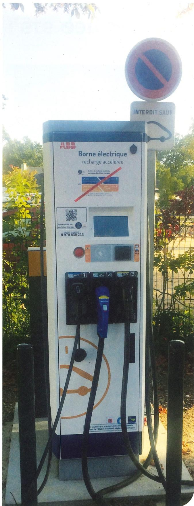
La borne de la commune peut recharger 2 véhicules électriques simultanément, quel que soit son modèle : voiture, scooter, vélo... De type accéléré, la borne délivre jusqu'à 18 kW de puissance ce qui permet la recharge jusqu'à 80 % des batteries en près de 45 minutes. En outre, celle-ci dispose de prises répondant aux différents standards des constructeurs automobiles (prises E/F, de type 2).
